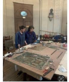
points de casse, autant de sources d'infiltration d'eau et d'air, qui ont été réparés et, parallèlement, toutes les baies ont été décaissées et « repolissées » pour permettre une homogénéité entre des verres d'époques différentes.
